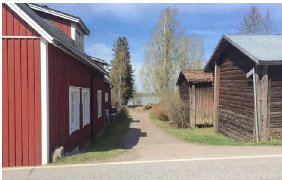
21. Saarelankuja Tuomalan kylässä Rantatien länsipuolella. Vasemmalla rakennuksen kivijalka on jäänyt kokonaan tien sisään. Myös oikeanpuoleinen aitta lahoaa tien pinnan nousun vuoksi. Samalla kujan liittyminen Rantatiehen on tullut jyrkäksi.
